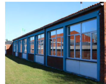
Eksempel på markerede betonrammer omkring vinduer og brystningsbånd jf. § 7.3.
