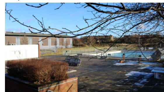
Hvidovre Friluftsbad set fra den eksisterende sti mellem Brøndager og Præstemoseskolen.
