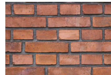
Eksisterende teglstensfacade i rødbrunlige nuancer jf. § 6.7.
