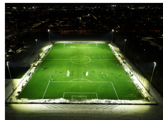
Referencefotos fra en eksisterende kunstgræsbane i Albertslund, der benytter samme type lysmaster. Det øverste billede er taget ved en lysstyrke fra masterne på 125 lux og det nederste billede ved 250 lux.
