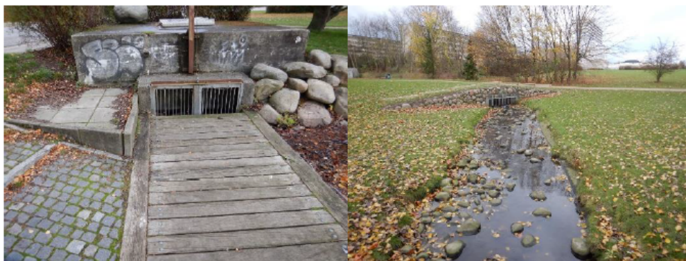
Figur 5-11. Afløb fra Rebæk sø (venstre), og tilløb med iltningskanal på nordsiden af søen (højre).
