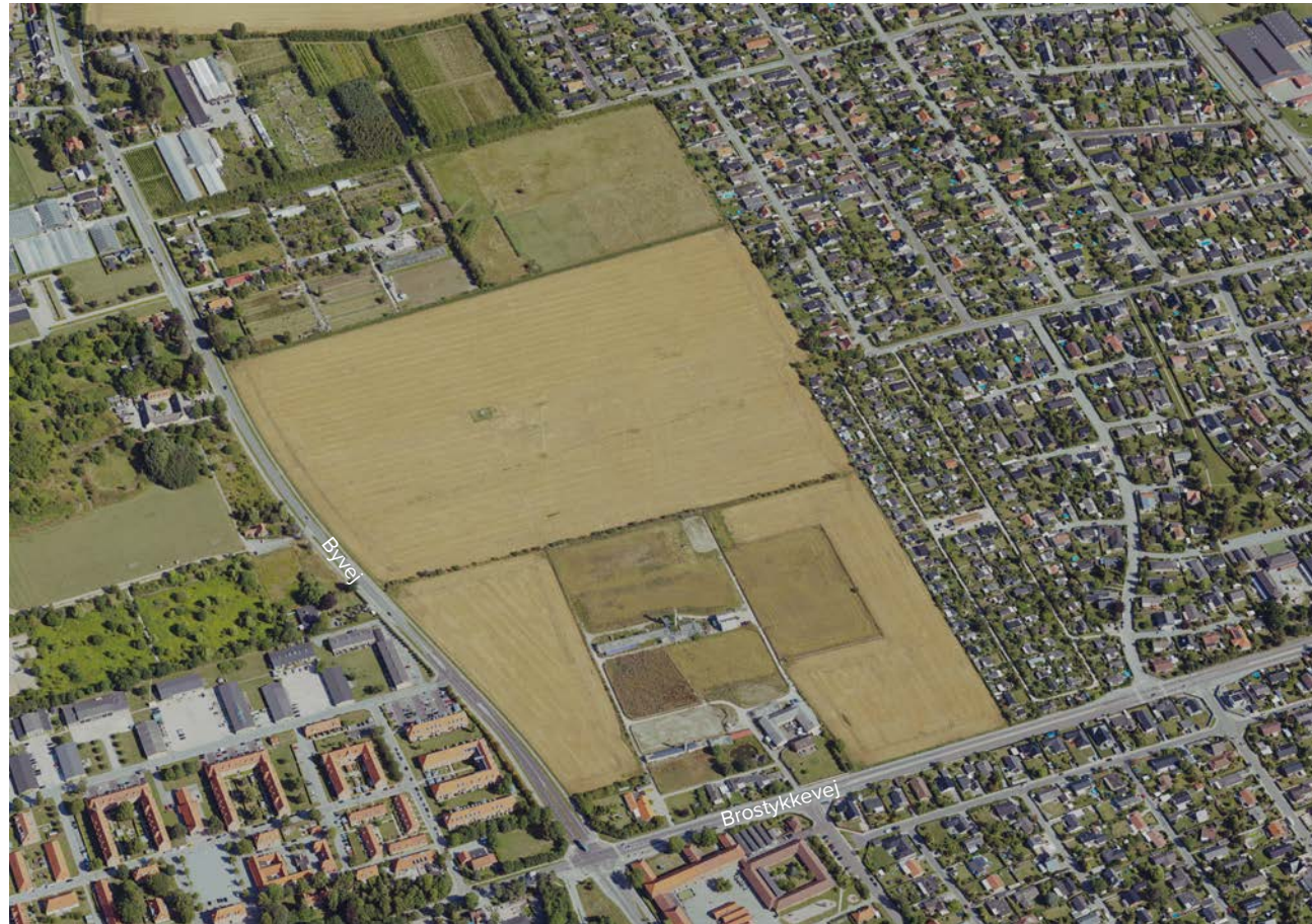
Luftfoto af området øst for Byvej og nord for Brostykkevej. © Geodanmark
